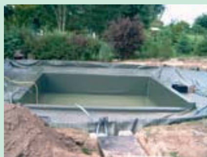
9 Schließlich fehlen nur noch das Substrat und die Pflanzen und das Becken kann befüllt werden...
