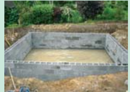
6 Der Schwimmbereich ist fast fertig. Die Wände müssen noch mit Beton verfüllt und anschließend verputzt werden.
