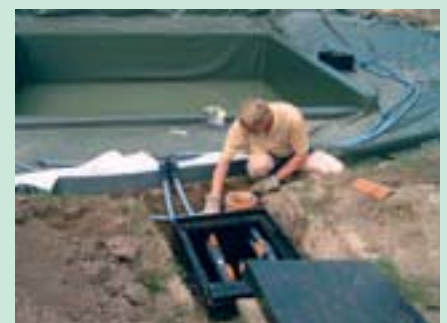
8 Der Einbau der speziellen Umwälz- und Filtertechnik erfolgt ebenfalls durch den Fachmann unter Einbeziehung des Bauherrn.
